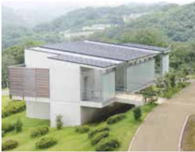
【工事名】西海橋公園トイレ建築工事 【構造】RC造1階建 延べ面積140.045㎡ 【工期】平成19年11月5日～平成20年3月28日
