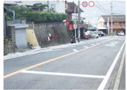
【工事名】白南風小学校校区通学路整備工事 【構造】側溝整備工 L=88.1m 【工期】平成20年9月25日～平成21年1月5日
