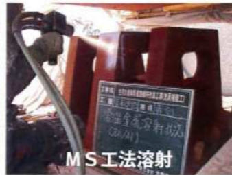
Plasファイヤー工法溶射
