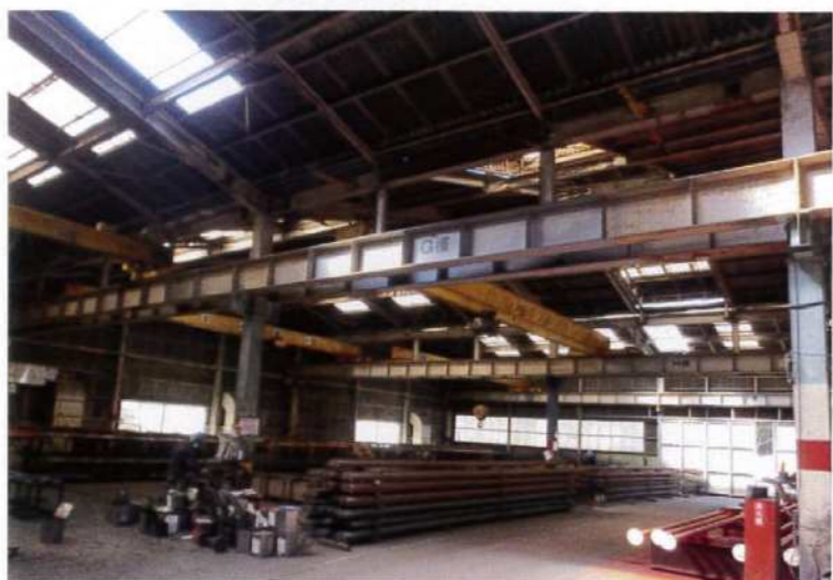
御橋第一防錆工場構内
