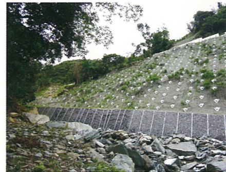
地山補強土工
